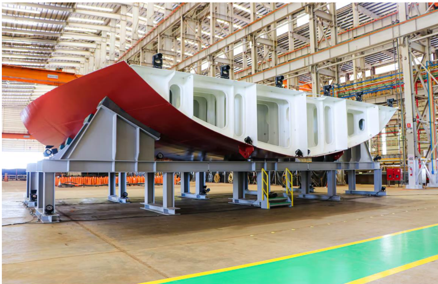
Construção do Navio Polar, executado pela Polar 1 e gerenciado pela Empresa Gerencial de Projetos Navais (EMGEPRON). Cerimônia de "batimento de quilha", no dia 17 de outubro de 2023, em Aracruz/ES Foto: MarinhadoBrasil/Divulgação
